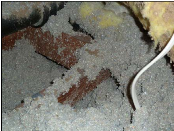
Uneven insulation
